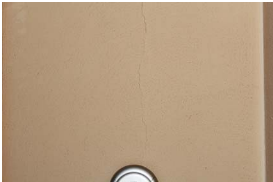
Bild 3: Erdgeschoss, Küche, Wandriss
