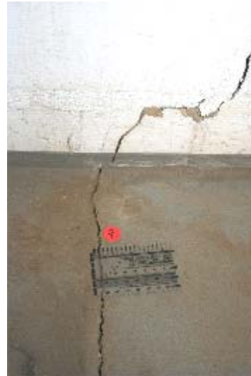
Bild 2: Kellergeschoss, Bodenriss
